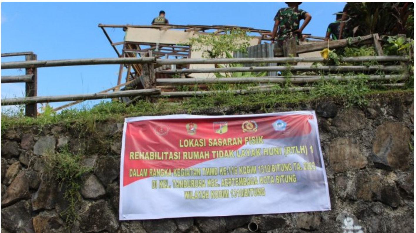
Kegiatan Pembangunan Rumah Tidak Layak Huni (RTLH) oleh Satgas TMMD Ke-116 di Kelurahan Tandurusa
