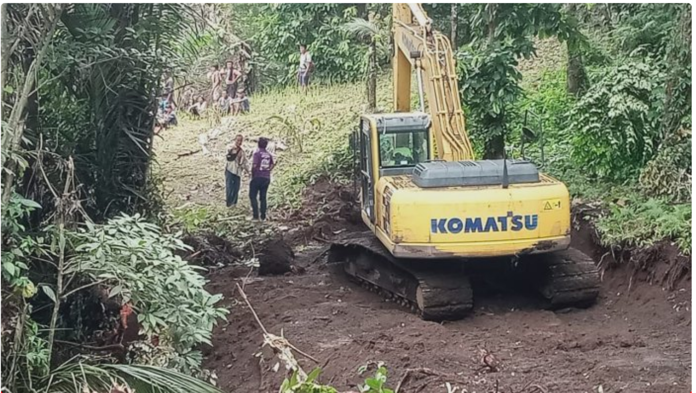
LokasibPekerjaan Perintisan Jalan TMMD Ke-116 Kodim 1310 Bitung di Kelurahan Tandurusa
