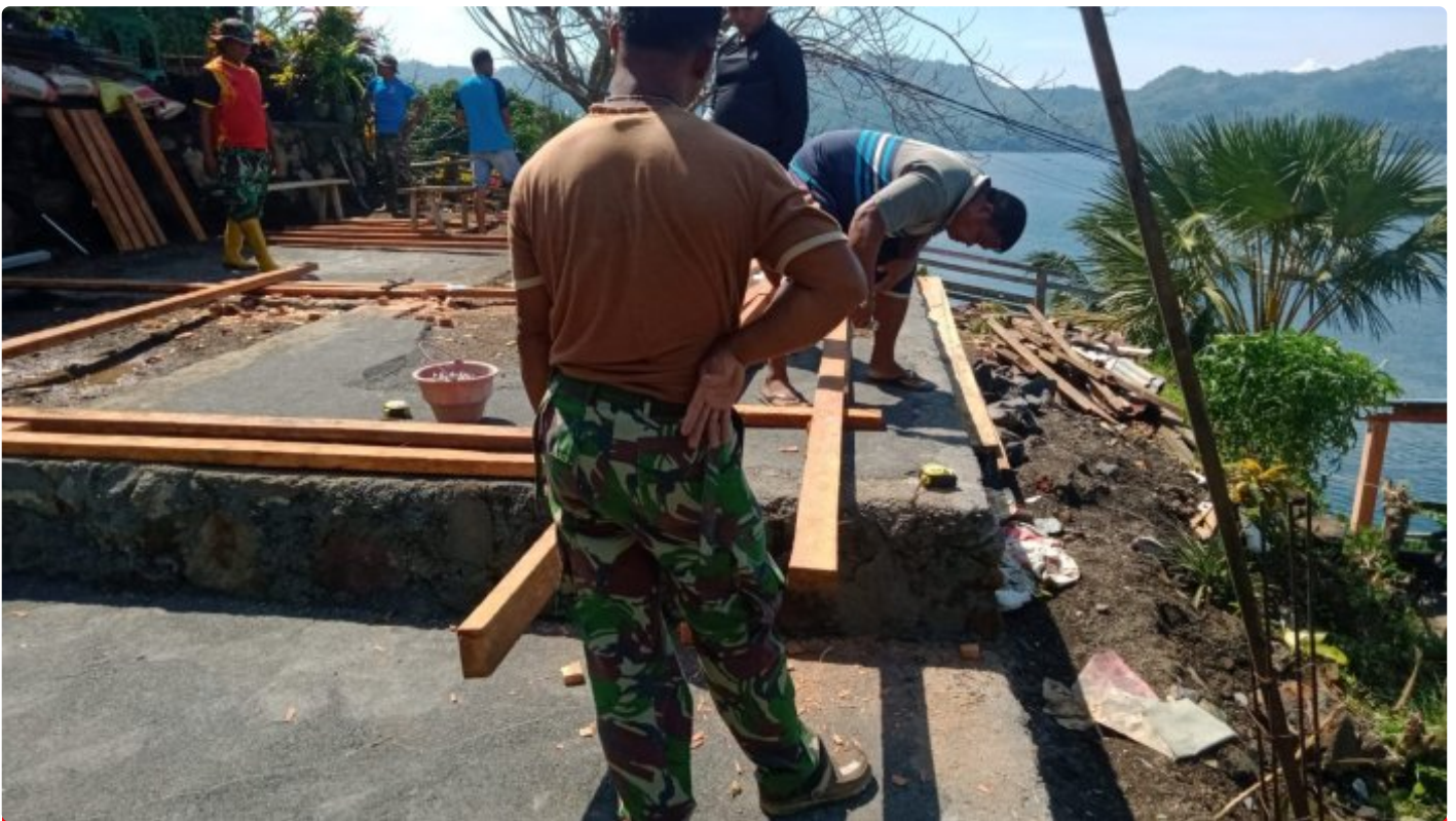
Satgas TMMD Ke 16, pada Pekerjaan RTLH Warga Kelurahan Tandurusa
